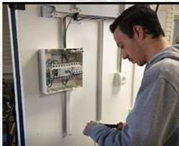
Montagem de quadros eléctricos
